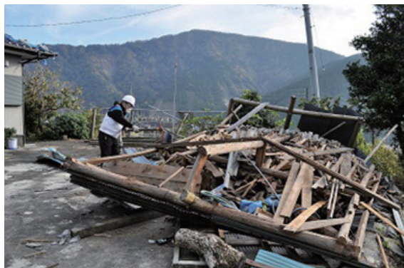
熊本地震で全壊した小屋の解体・分別破棄をしました
